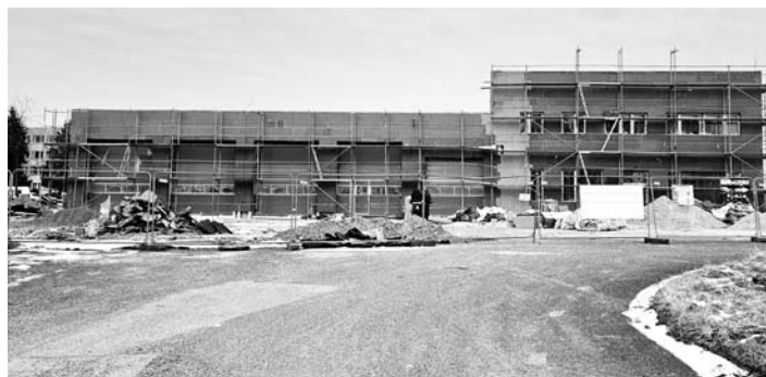
Nowa remiza w Woli już teraz robi wrażenie
