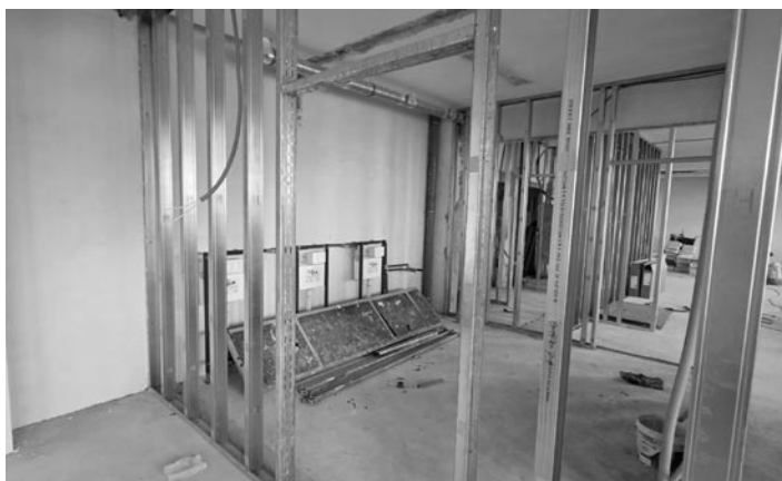
Widać już zarys ścian w nowym żłobku w Woli
