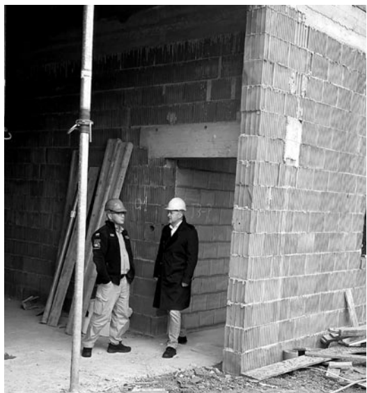
Wójt spotkał się na budowie remizy z komendantem powiatowym PSP
