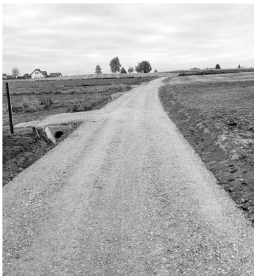
Zakończono roboty na ul. Ogrodników w Górze, drodze dojazdowej do gruntów rolnych
