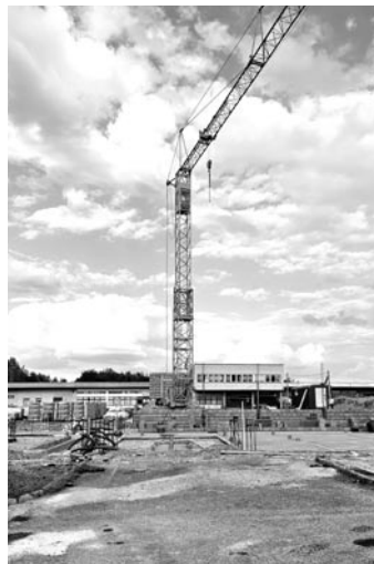
Na placu budowy remizy w Woli (FOT. PK)
