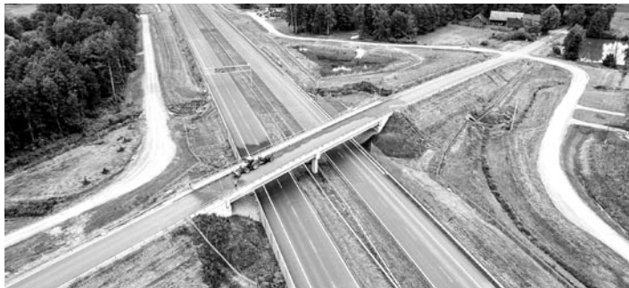
Wiadukt nad nową drogą w Gilowicach
