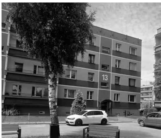
Do zdarzenia doszło w bloku nr 13 (FOT. PK)
