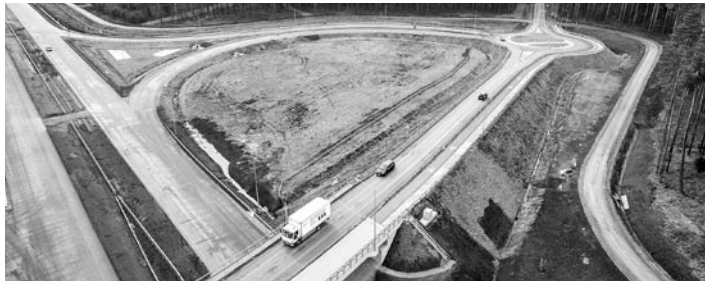
Węzeł w Woli z lotu ptaka
