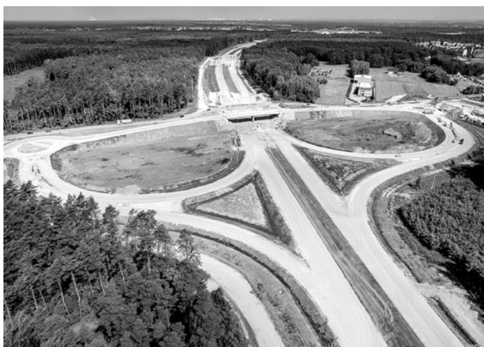
Budowa węzła drogi ekspresowej S1 w Woli (FOT. GDDKIA)
